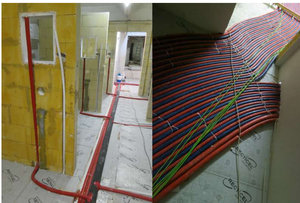
Aanleg van de douches.
